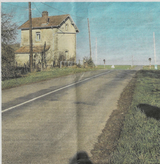
La maison, encore habitée il n'y a pas si longtemps, comporte une pièce en bas et un étage pour une surface de 52 m 2 .
